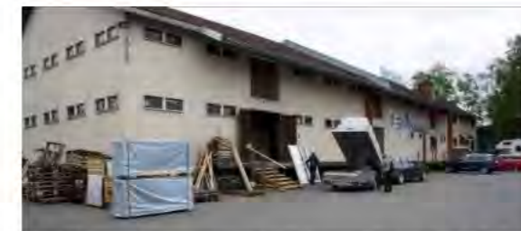
Suosiolan teollisuusalueella, osoitteessa Aittatie 10, on säilynyt Salokankaan suunnittelema suurikokoinen ja yksityiskohdiltaan huolellisesti detaljoitu puurakenteinen teollisuusrakennus vuodelta 1947.
