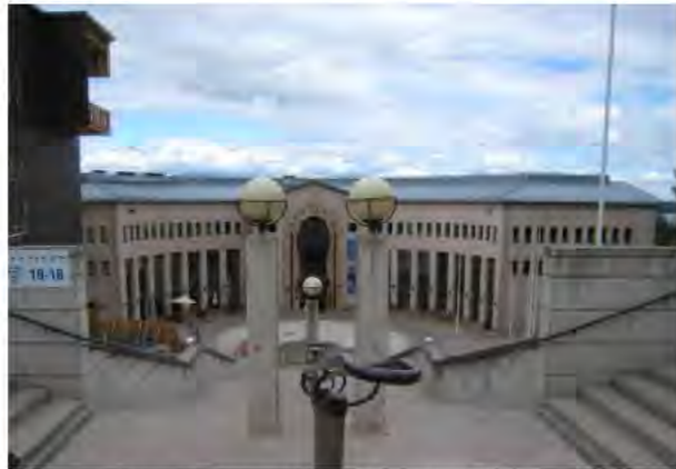
Keskustan luoteisosaan valmistui kansainvälisen arkkitehtuurikilpailun tuloksena 1992 Tanskalaisten Claus Bonderupin, Sören Birchén ja Ellen Waaden suunnittelema Arktinen keskus Arktikum. Rakennukseen liittyy tuubimainen rinteeseen sijoittuva lasigalleria sekä Suomessa harvinaiseksi jäänyttä postmodernia tyyliuunnata edustava sisäänkäynti-rakennus.
