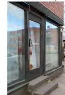
Jaakonkatu 2, maantasokerroksen kupari- lasijulkisivun yksityiskohtia
