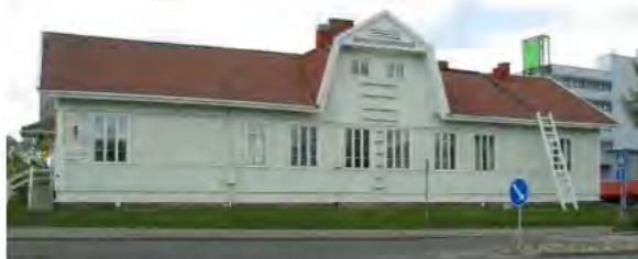
1908 toteutettu jugendtyylinen asemarakennus on arkkitehti Thure Hellströmin suunnittelema.
