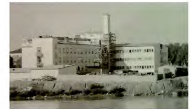
1939 valmistunutta funktionalistista tyyliuuntaa edustavaa lääninsairaala laajennettiin 1962 (alempi kuva). Arkkitehti Jussi Paatelan suunnittelemaa rakennusta on myöhemmin korotettu ja väritystä on muutettu. Julkisivun alkuperäinen ilme on näiden muutosten myötä muuttunut merkittävästi.
